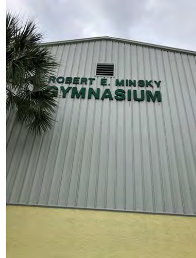
Photo: Gym Exhaust Fan
