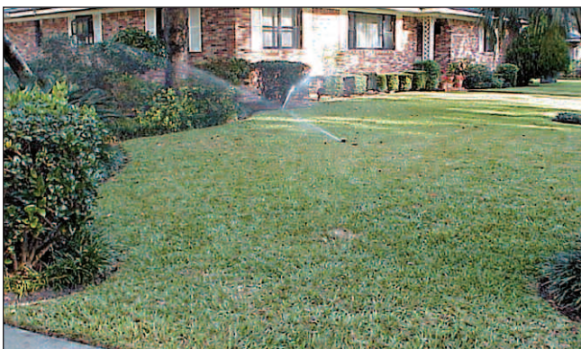
Figura 8. Dise1o deficiente; el sistema no provee los niveles requeridos de agua. El 1rea necesita ser re-zonificada, separando el c3sped de las otras plantas.
