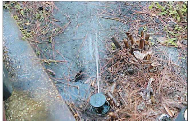
Figura 10. Objetos interfiriendo con el patr3n de dispersi3n, lo que resulta en una uniformidad y una distribuci3n pobre.
