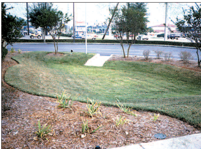
Figura 2. Áreas de retención cubiertas con césped complementan nuestros espacios exteriores y protegen nuestro medio ambiente.
