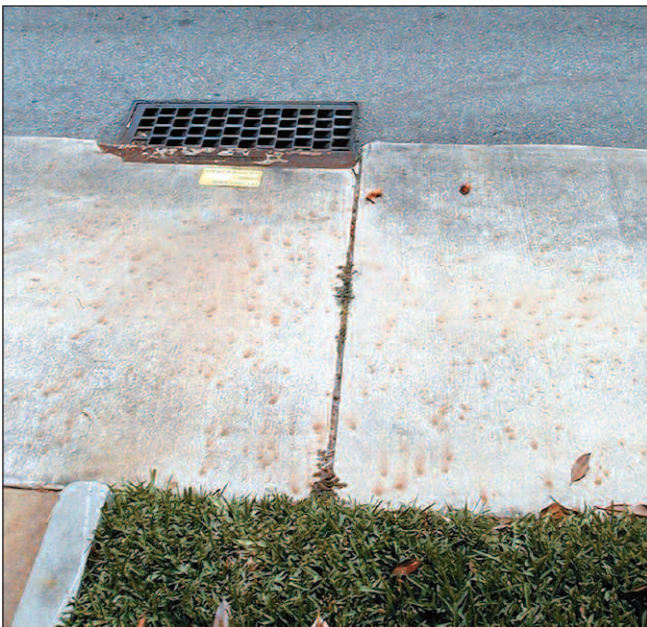
Figura 3. Una técnica pobre de fertilización desperdicia fertilizante, causa manchas y contamina los cuerpos de agua.
